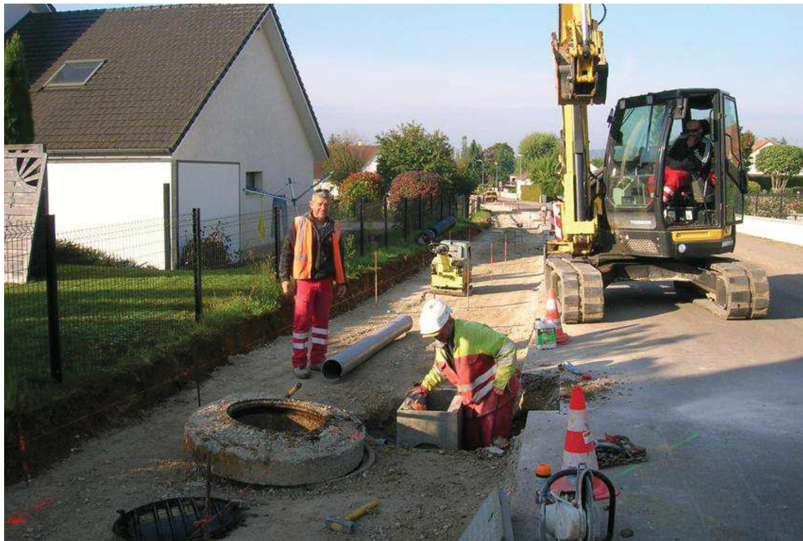
Travaux pour l'écoulement des eaux pluviales.
