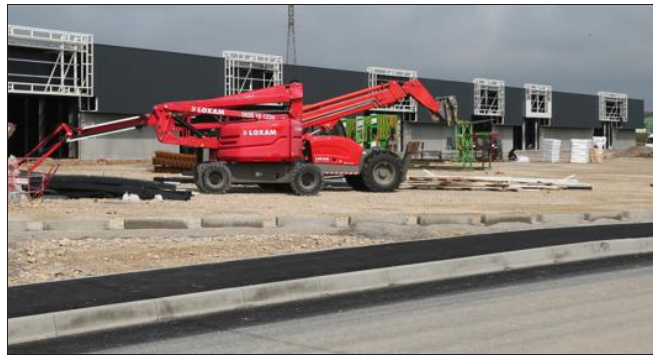
À Pusey, les travaux ont bien avancé sur la zone Oasis 3. Les premières ouvertures sont prévues autour du 20 août. Photo ER/Bruno GRANDJEAN
