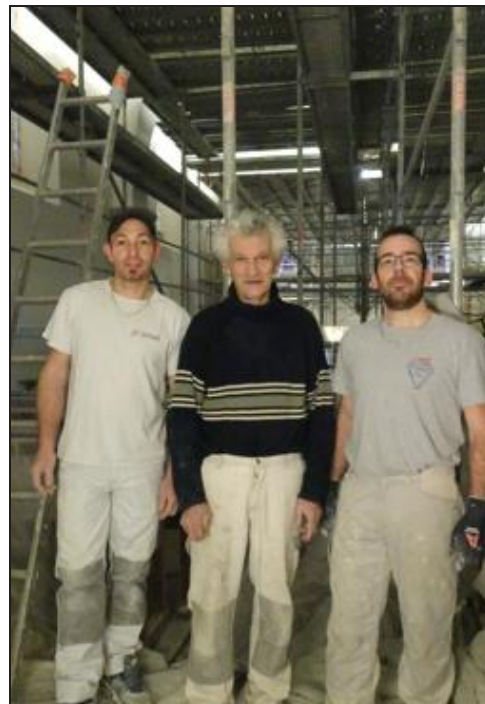
Les ouvriers œuvrent à sa remise en valeur. Photo ER
