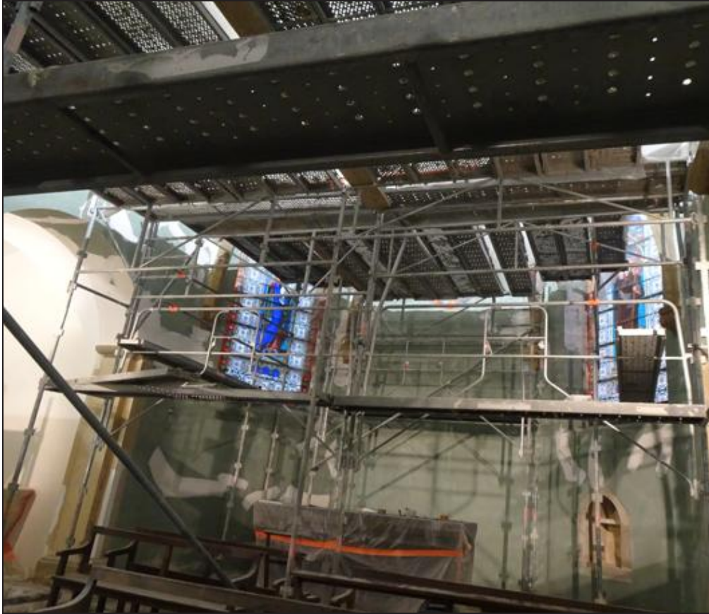
Les échafaudages ont pris place dans l'église. Photo ER
