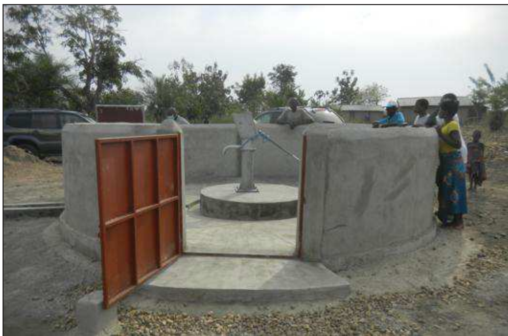
Un forage terminé, équipé d'une pompe à bras. Photo ER
