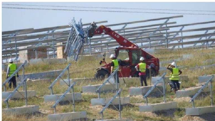
L'installation des panneaux bifaciaux. - © Philippe Combrousse
