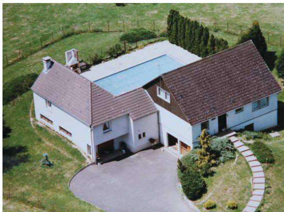
La maison a été construite dans les années 70 sur environ un hectare de terrain. Reproduction D.R
