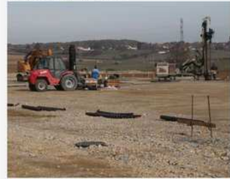
Les travaux de la ZAC Oasis 3 ont débuté début juillet. Photo Bruno GRANDJEAN
